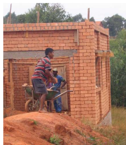
Chantier de construction
