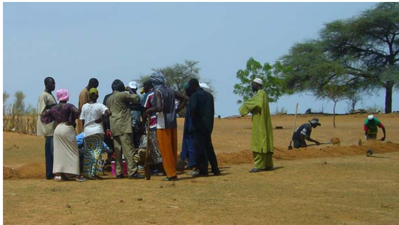
Réalisation des tranchées
